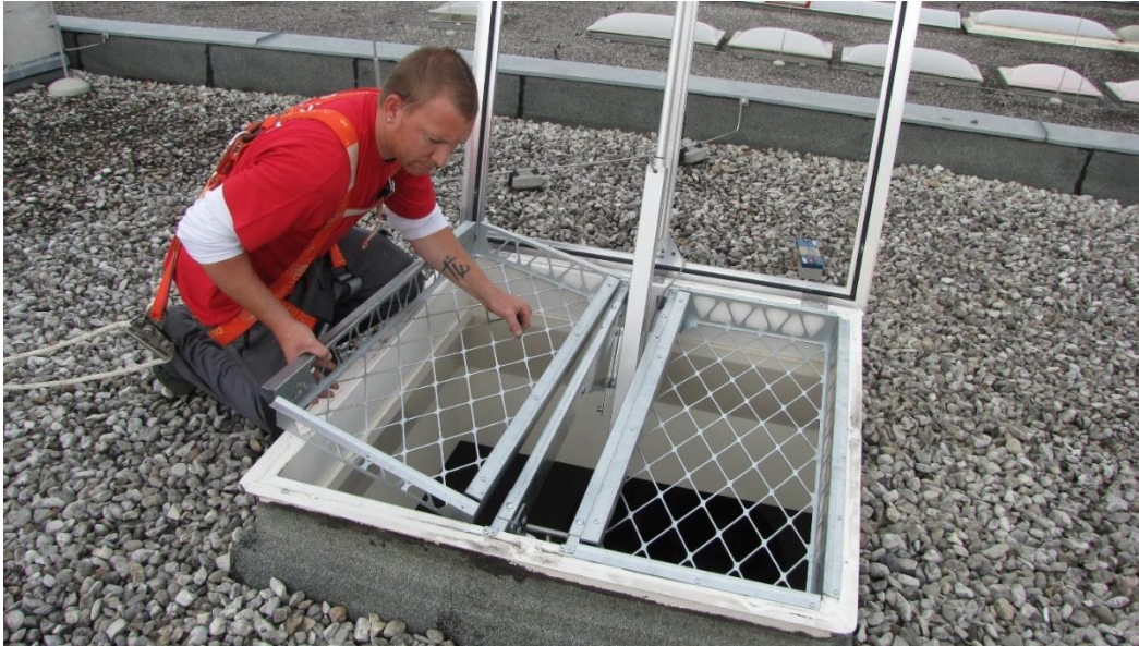
Durchsturzsisicherung in Rauchabzugsöffnung nachträglich in Bestand eingebaut. © Sadler Lichtkuppeln
