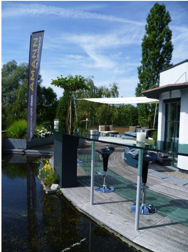
Bild Dachterrasse mit Begrünung und Wasserfläche– Lasten gleich hoch wie davor im Bestand mit Waschbetonplatten auf 5 cm Splittbett. ©AMANN die DachMarke
