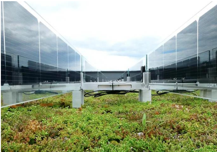
Over Easy PV System auf Gründach aufgesetzt
